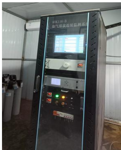
竖炉烟气在线监测设备
