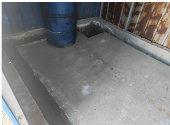
危废库地面防渗
