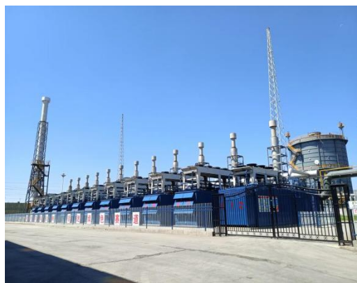
内燃机发电机组（部分煤气用于发电）
